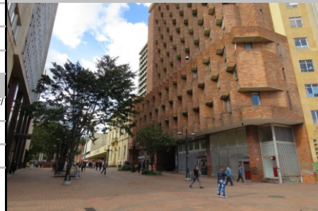
Fuente: Equipo Fotografía PEMP Patrimonio Inmueble
